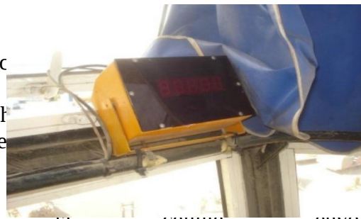
Figure7 : Afficheur de limiteur de charge
