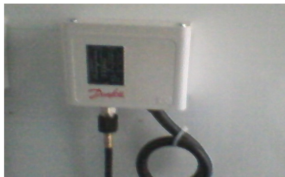
Figure : pressostat de régulation
