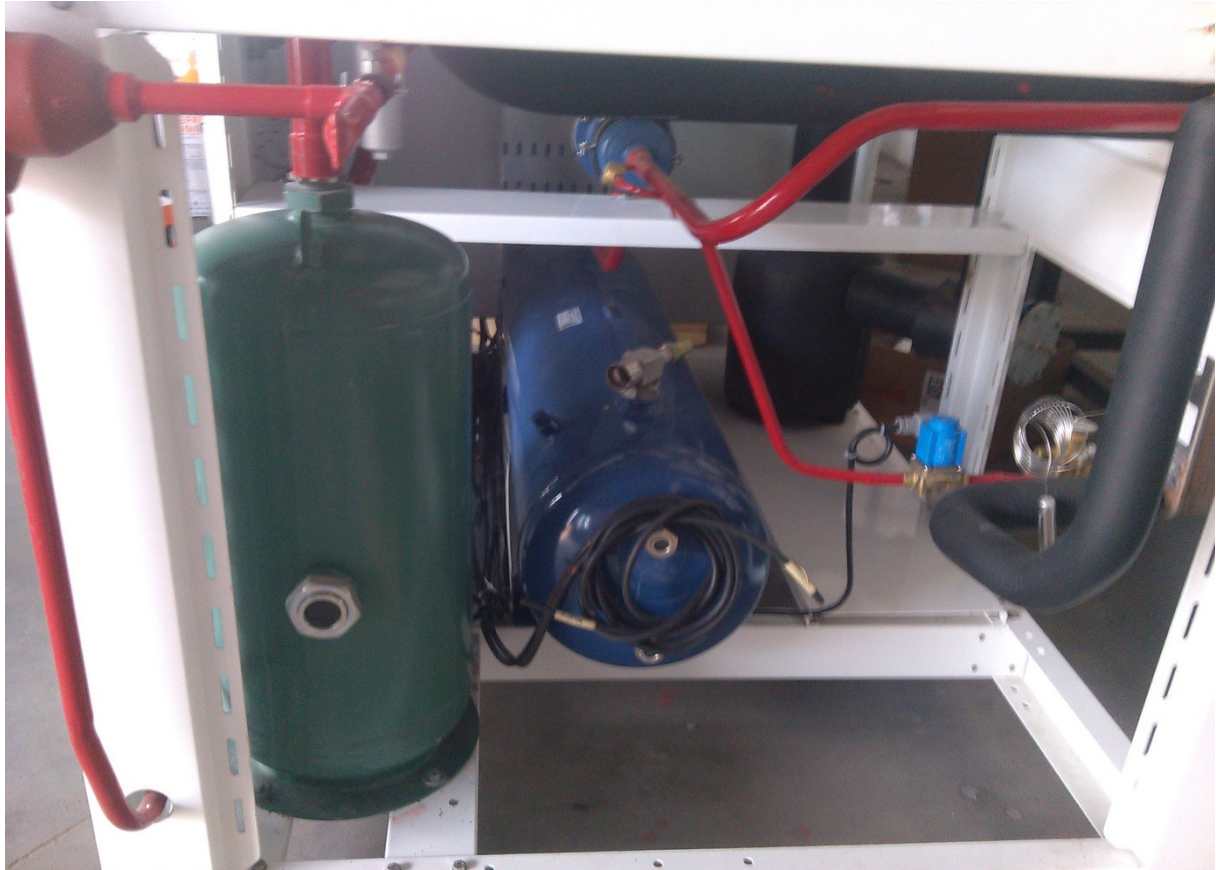
Figure : La mise en place de réservoir de liquide et de séparateur d'huile dans la centrale
