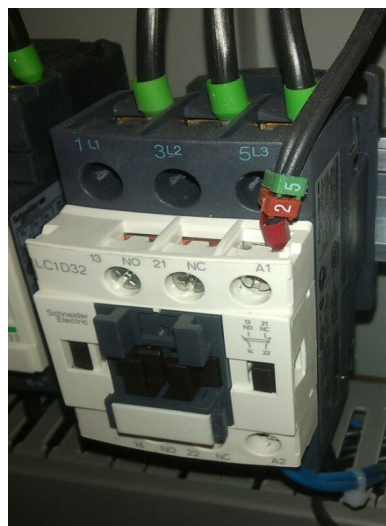
Figure : Bloc de contacts auxiliaires
