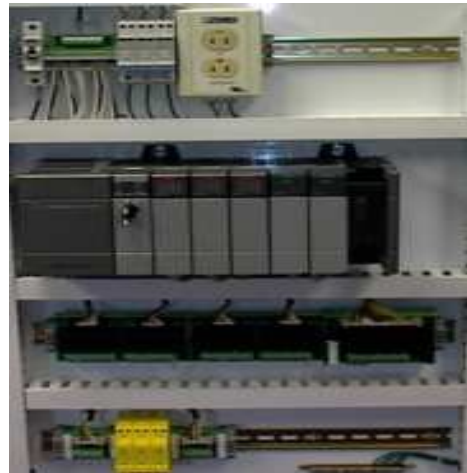
Automate programmable industriel (API) Siemens
