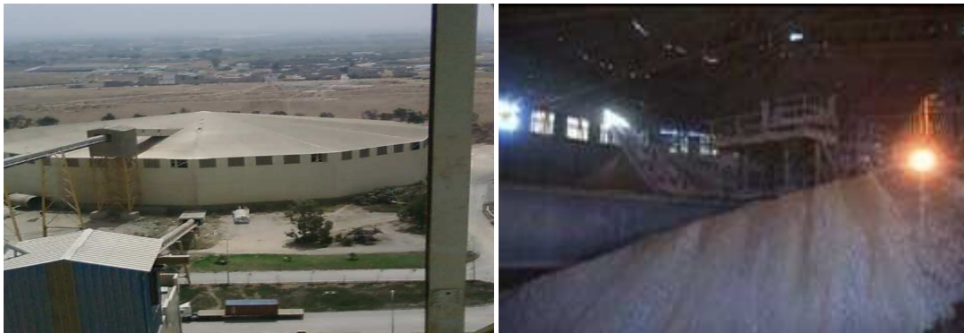
Figure 1.2.2. Vue du Pré homogénéisateur
