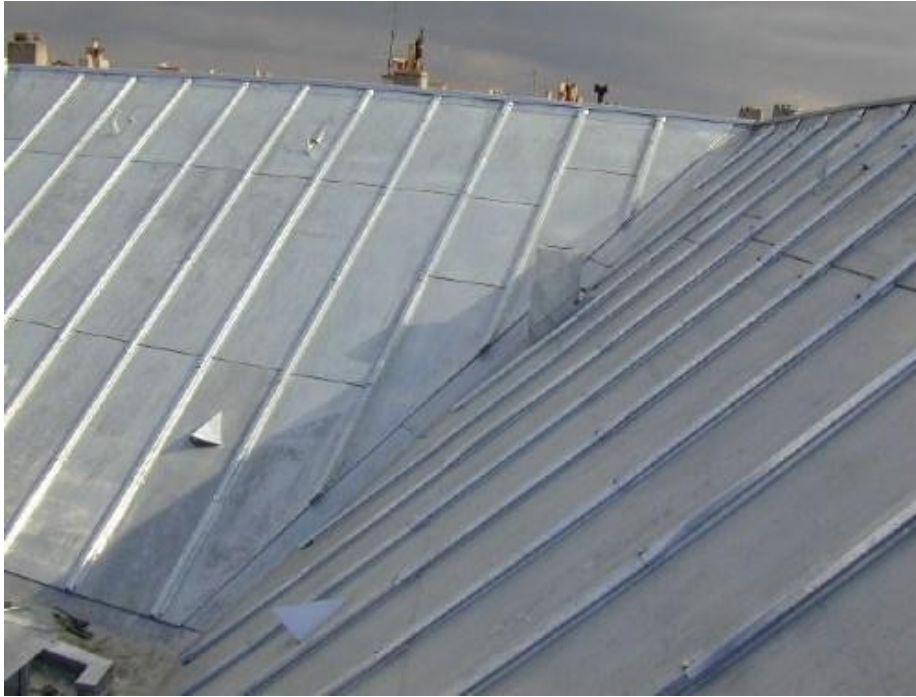
Toit en zinc
