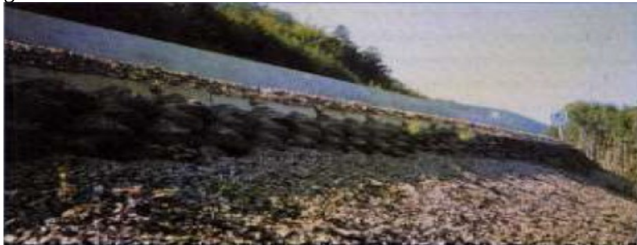
Figure (IV .19) : Ouvrage en Pneusol
